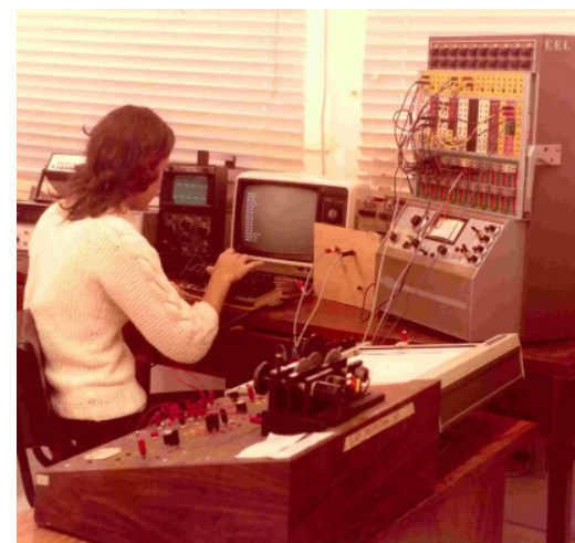
Implementação de lógica de controle usando um computador analógico.
