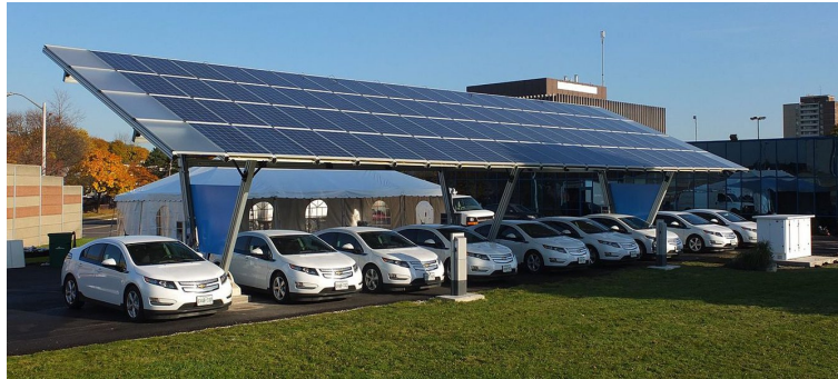
Figura 1: Estação de carregamento de veículos elétricos.
